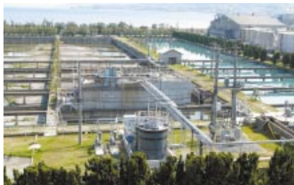
薬液の流出防止対策（岩国事業所）
