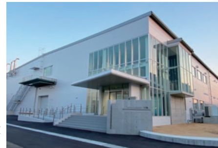
メディカル製品の研究棟 「メディカル研究所」
